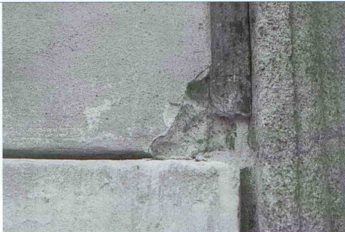
Fot. 3. Odkrywka nr 1 – widok ogólny
