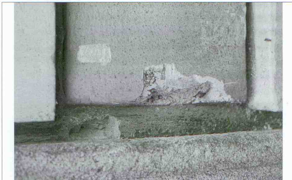
Fot. 7. Odkrywka nr 3 – widok ogólny
